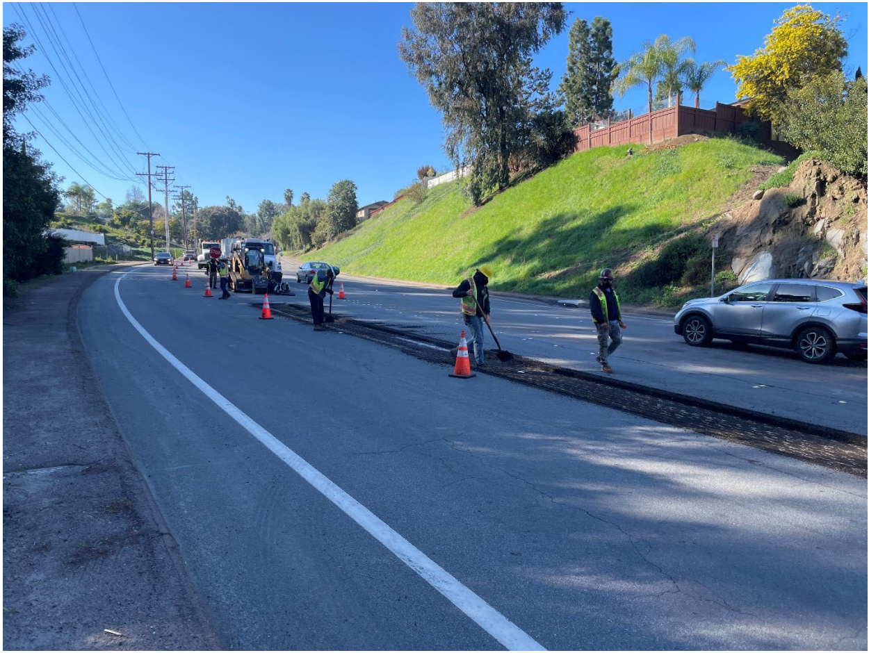
El Cajon - Asphalt Spot Repairs- Avocado Ave.
